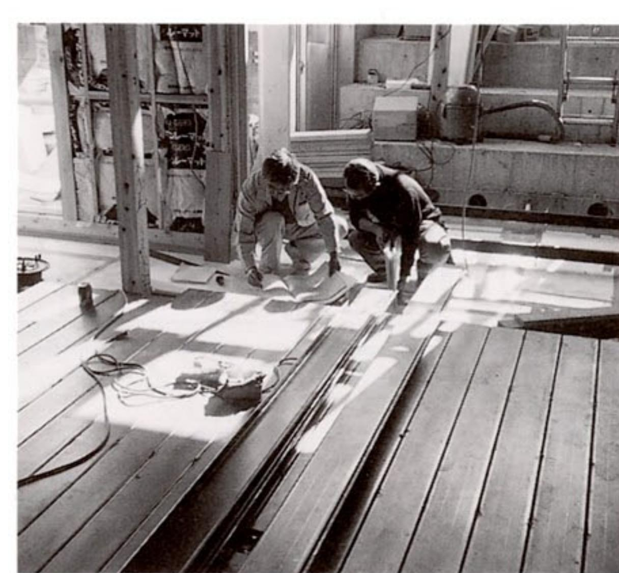
施工中の鉄骨・鉄板で床を組んだ二重床(\*)
