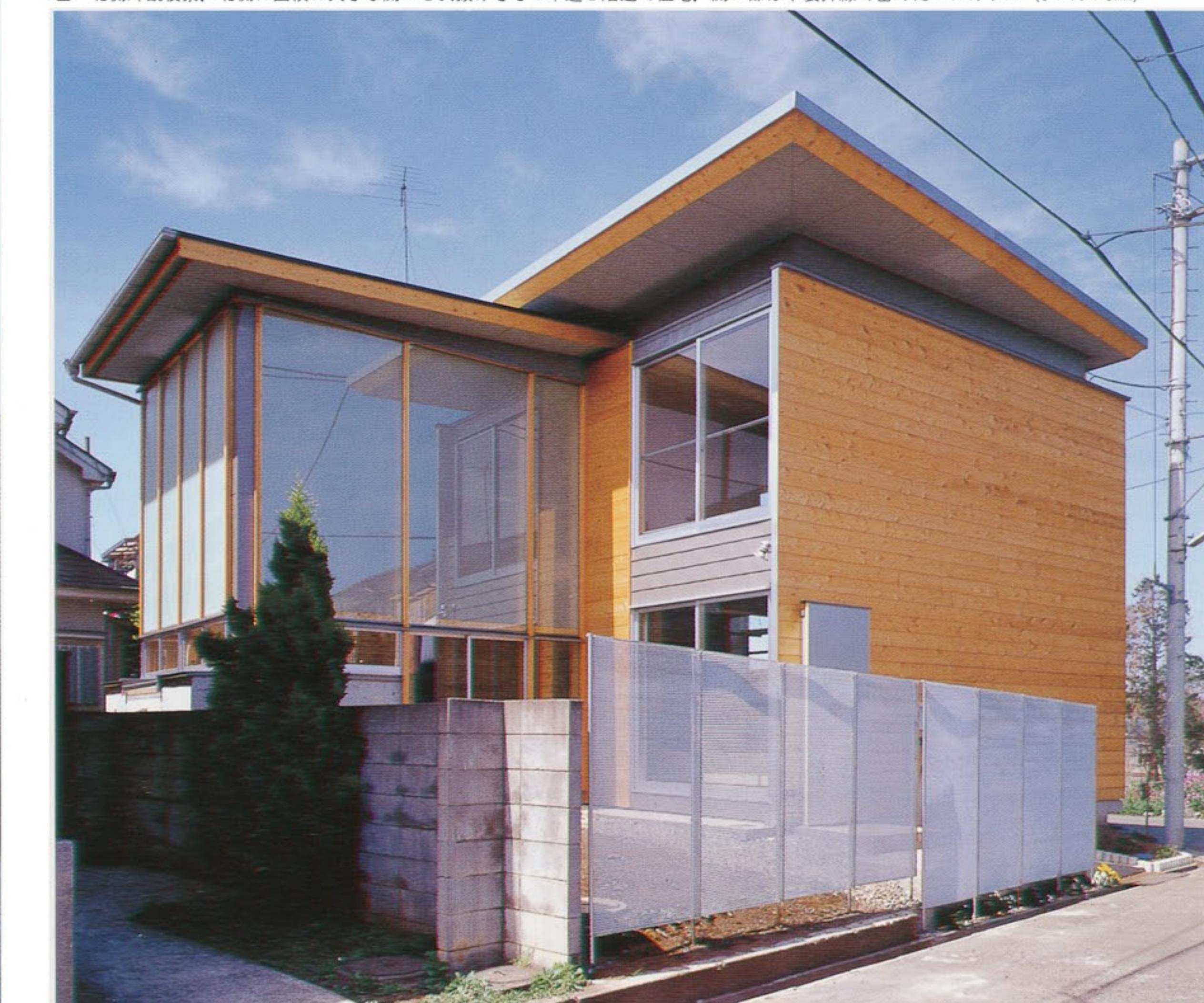
東側より見通す。左手、木製押縁による開口部内部は吹抜けで、上部屋根面には集熱ガラスがある。開口部はペアガラス（5+6+5mm）、外壁は通気層が設けられ、12mm厚のサワラ材のオイルフィニッシュ仕上げ。断熱効果を上げるために屋根は二重で、可能な限り庇を出している
