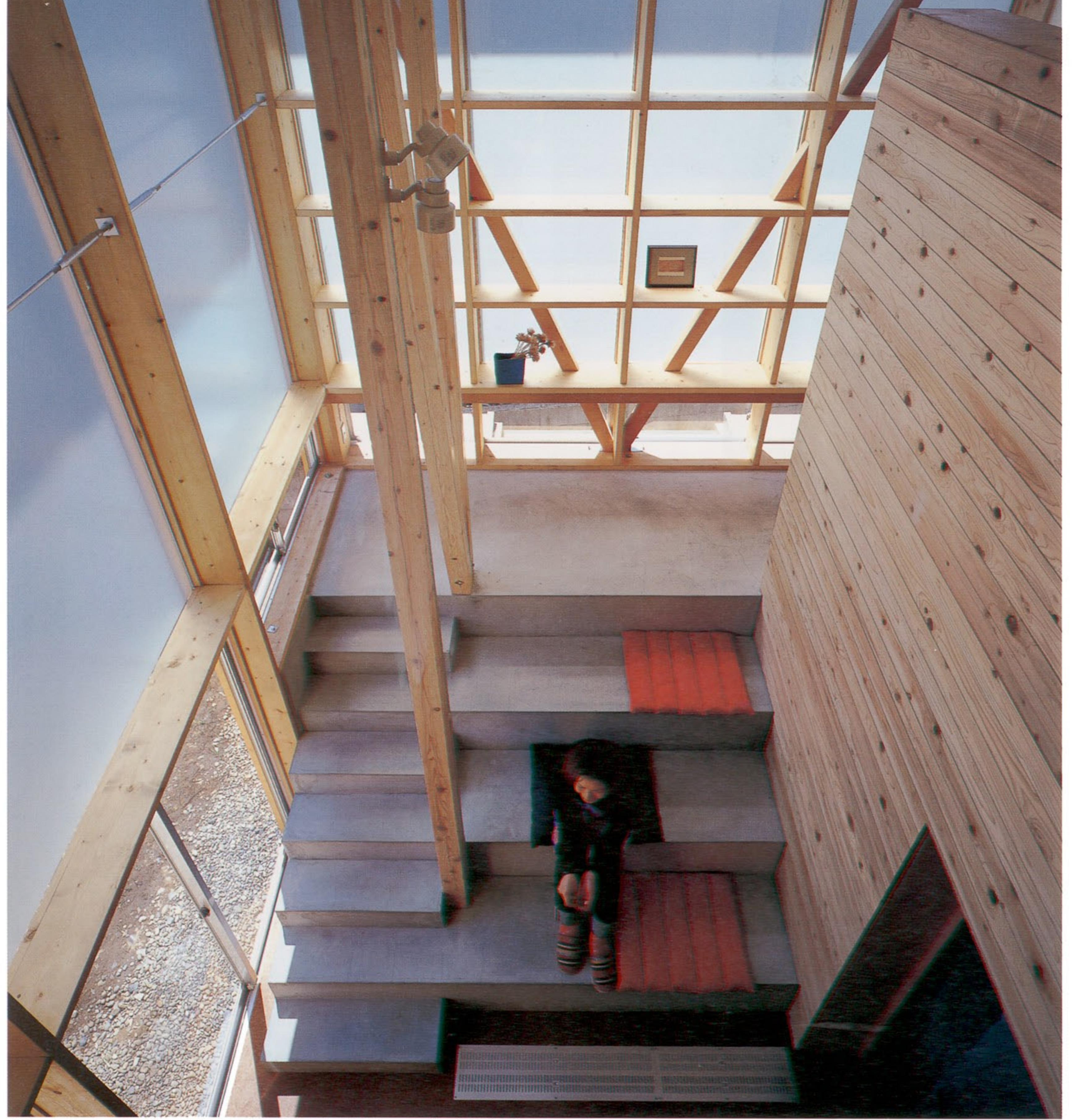
「ゴロゴロデッキ」見下ろし、2面をガラス張りにした立体土間空間。2"×4"材を窓枠兼柱兼飾り棚として利用している
