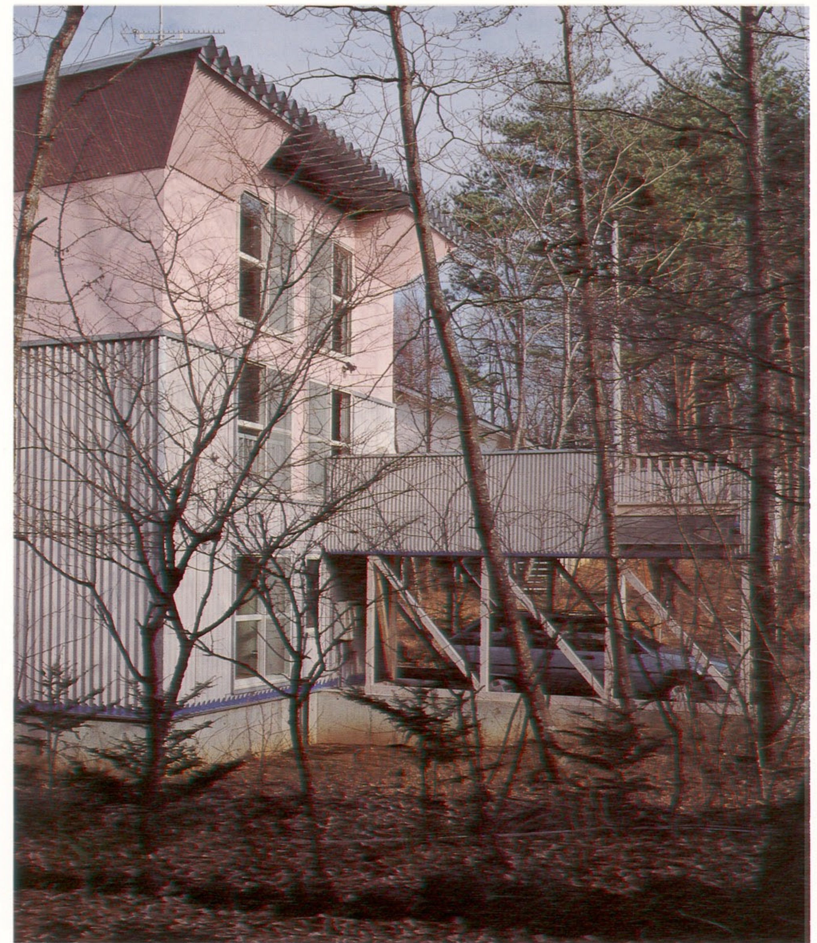
▲南面開口部とバルコニー廻りを見る
