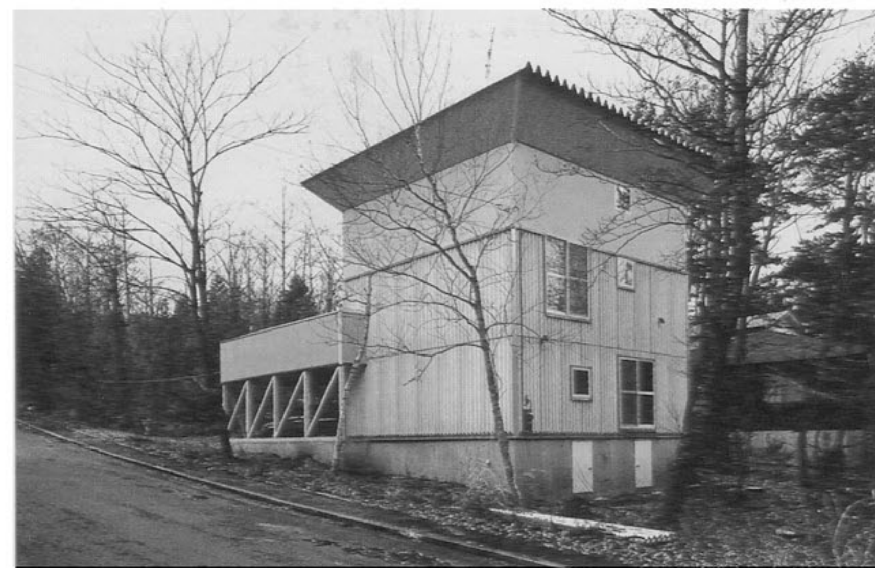
▲東北側より見た外観
